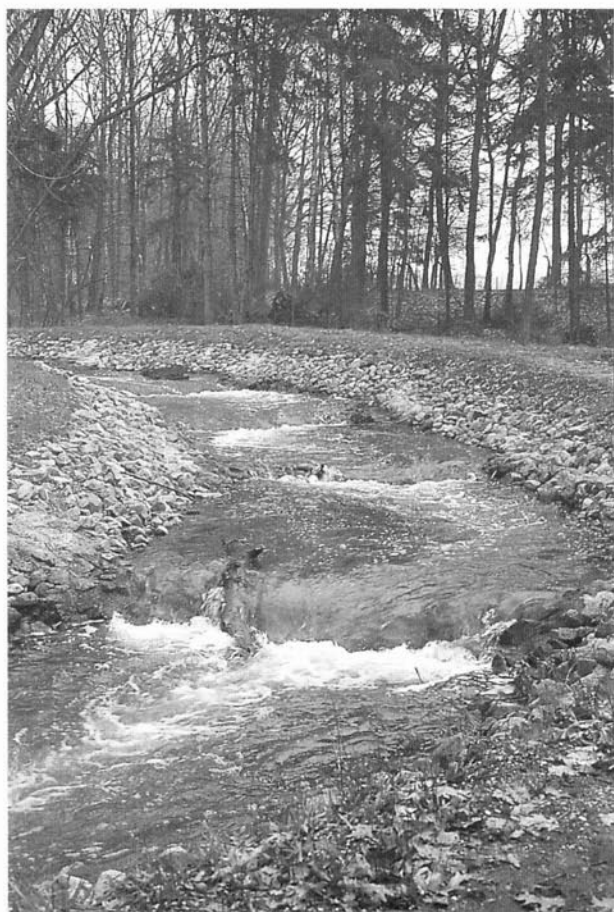
FIGUUR 6. Vistrap in de Swalm die door de grote stroomsnelheid van het water waarschijnlijk niet passeerbaar is voor de meeste vissoorten.
